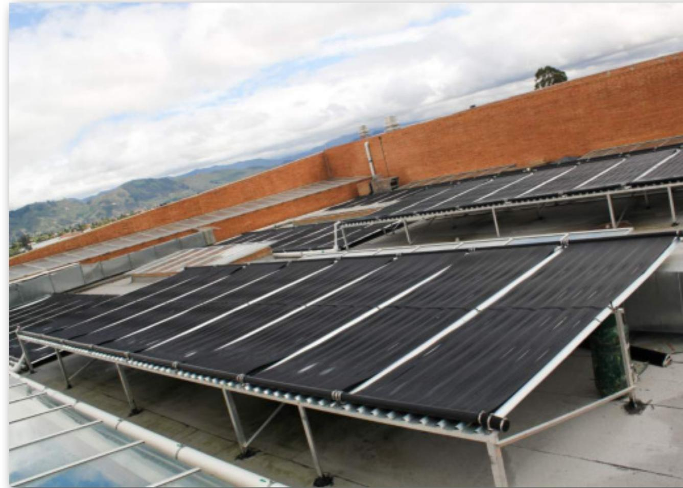
Colectores solares de polipropileno
