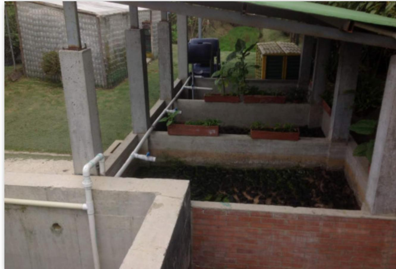
Así mismo, el AQUACAM (mezcla y suministro de aire) se encuentra apagado. La ausencia de una nueva carga de agua, mezcla y aireación produce un ambiente ideal para la separación de sólidos suspendidos en el líquido.
